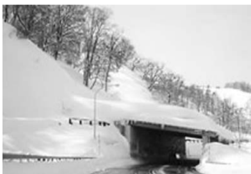
防雪施設のスノーシェッド
